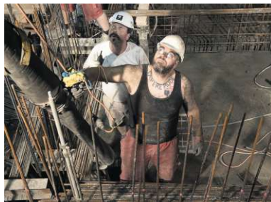
In drei Schichten, rund um die Uhr, ziehen die Männer den Betonurm bis auf eine Höhe von 118 Meter.
