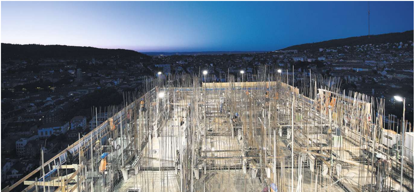
Die Arbeiter auf dem neuen Swissmill-Silo haben in dem Gewirr aus Armierungseisen keinen Blick für die Schönheiten der Stadt, die ihnen zu Füssen liegt.
